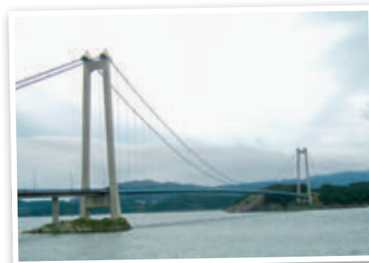
Stordabrua sett fra Føyno. Trekantsambandet åpnet i april.
