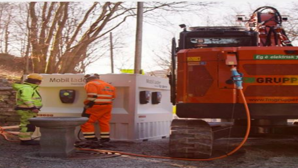
den nye 9-tonns Zeron-maskinen fra Nasta ved hjelp av en mobil lade
