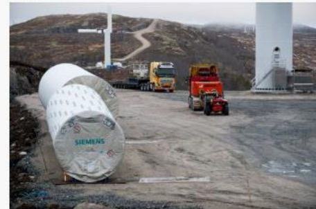
Det skal skje med arbeid i forbindelse med arbeid på en av store leverbare ved en vindturbin i Tonstad vindpark, lørdag kveld. Foto: Kristian Jacobsen
